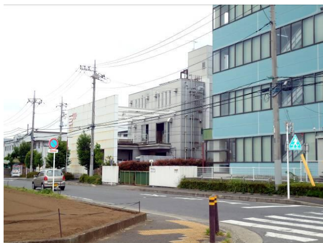
平成8年に整備された平沢工業団地
